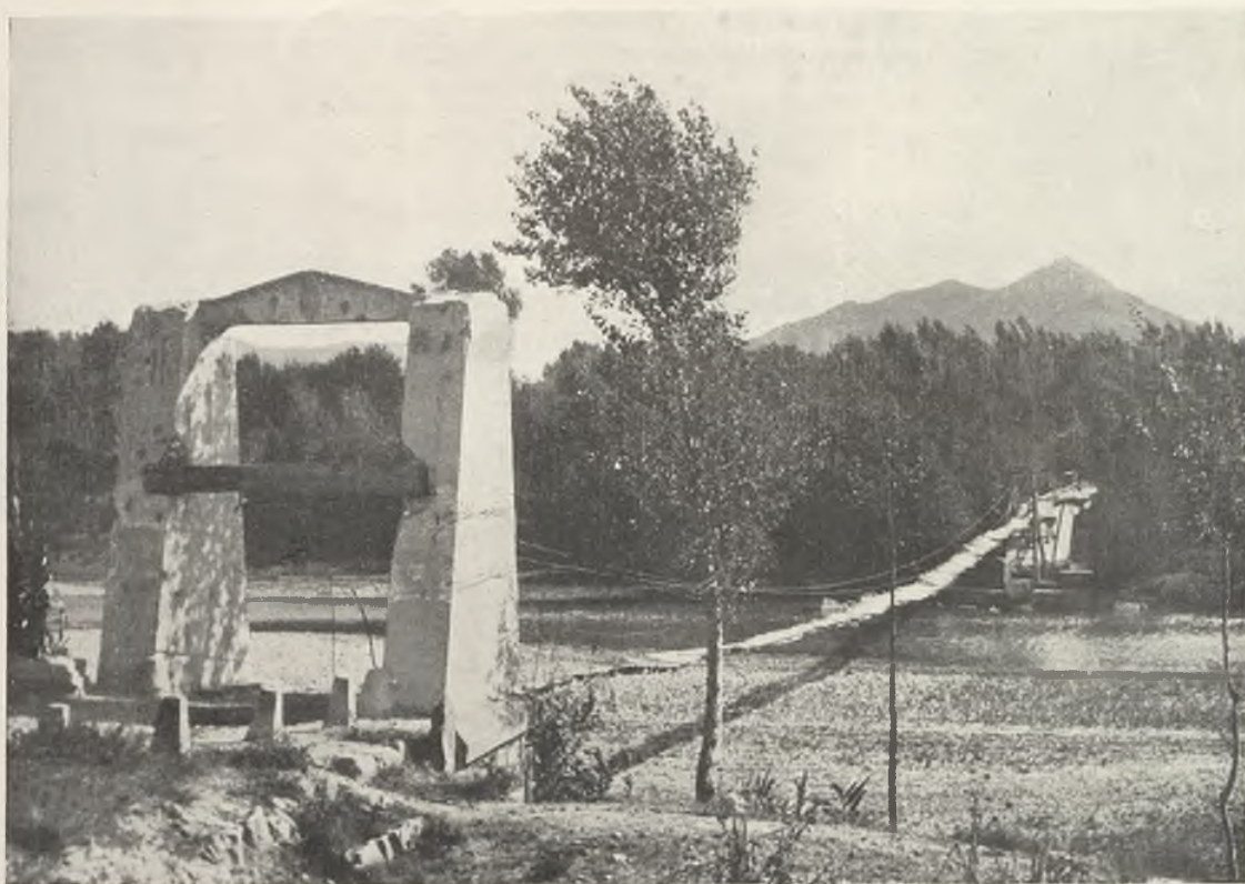
ARTESA DE SEGRE.—Antigua pasarela.
