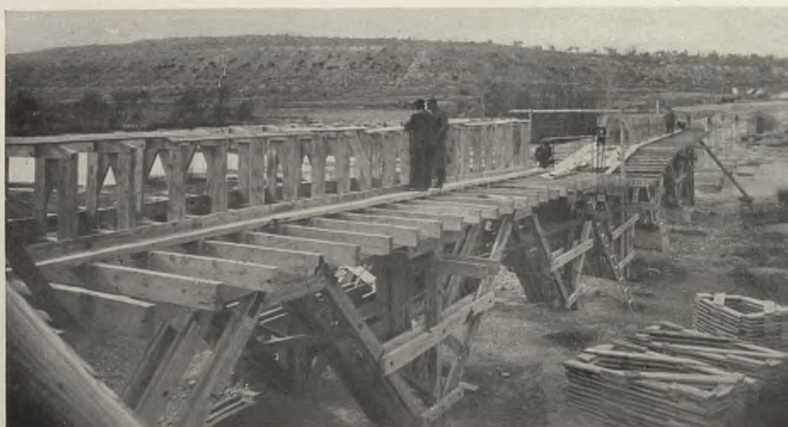
ARTESA DE SEGRE.—Encofrados y cinchas del puente.
